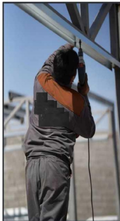
نصب رانر در زیر سقف دقیقاً به موازات را تر کف
