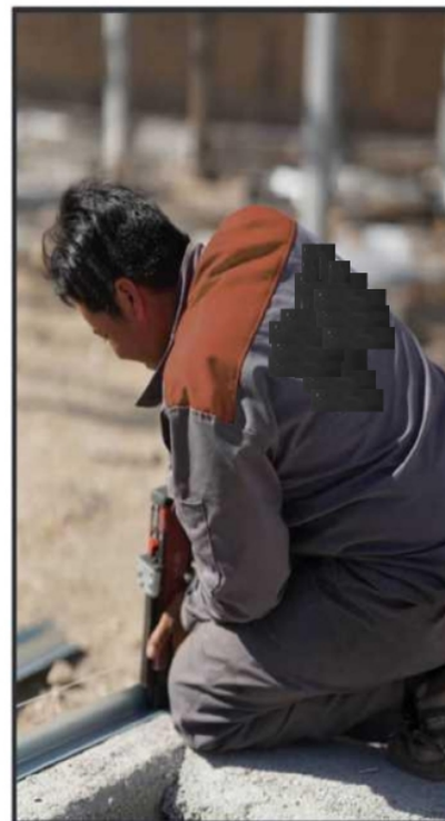
نصب رانر در کف و بر روی بتن
